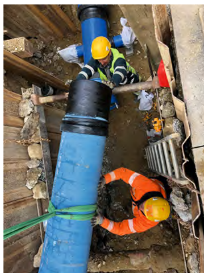
Einige der vielseitigen Einsatzmöglichkeiten der FZM-Gussrohre: im unwegsamen Gelände sowie im gespriessten Graben.
