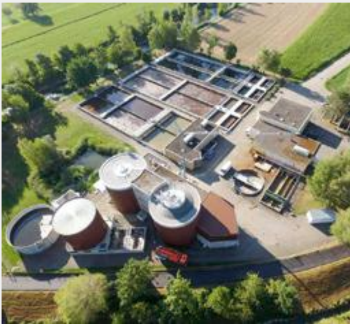
Fig. 3 Vue aérienne de la station d'épuration de Niederglatt. La STEP a fait recouvrir le stockeur boues d'une couverture étanche aux gaz dans le cadre du programme de promotion de South Pole.
