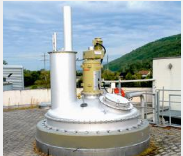
Fig. 4 Grâce à la couverture étanche aux gaz, la STEP d'Aarburg fait des expériences positives en matière de réduction des émissions de méthane et a déjà pu compenser les investissements grâce au programme de promotion de South Pole.
